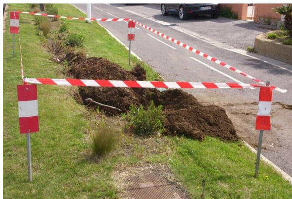
Photo 18 : Balisage des fouilles
