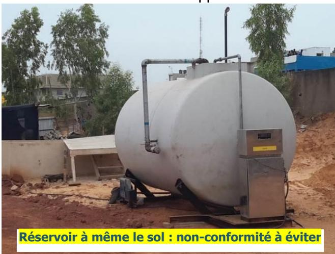
La cuve à gasoil devra être surélevée et une dalle étanche **d'un volume égal à 110% du volume maximum de la cuve la plus grande** devra être aménagée avec un système d'étanchéité qui n'autorisera aucune infiltration en cas de déversement.
